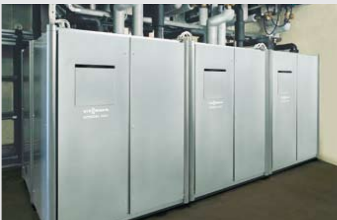
Vitocal 300 kaszkád- rendszer, 600 kW feletti összteljesít- ménnyel
