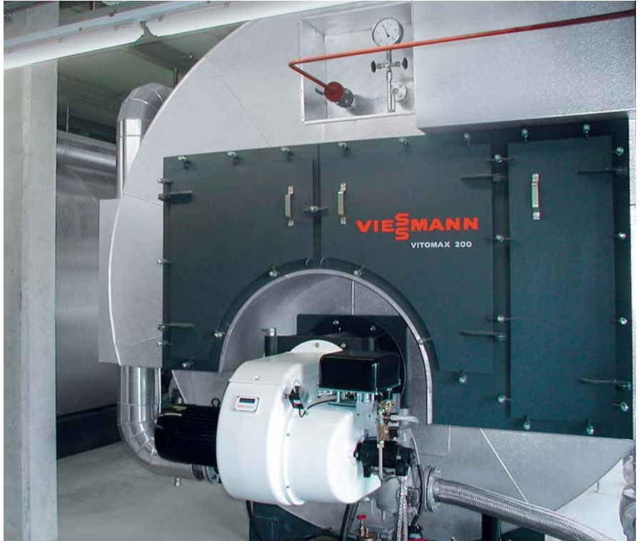
Bild 12: Dampferzeuger mit einem Abhitzezug
