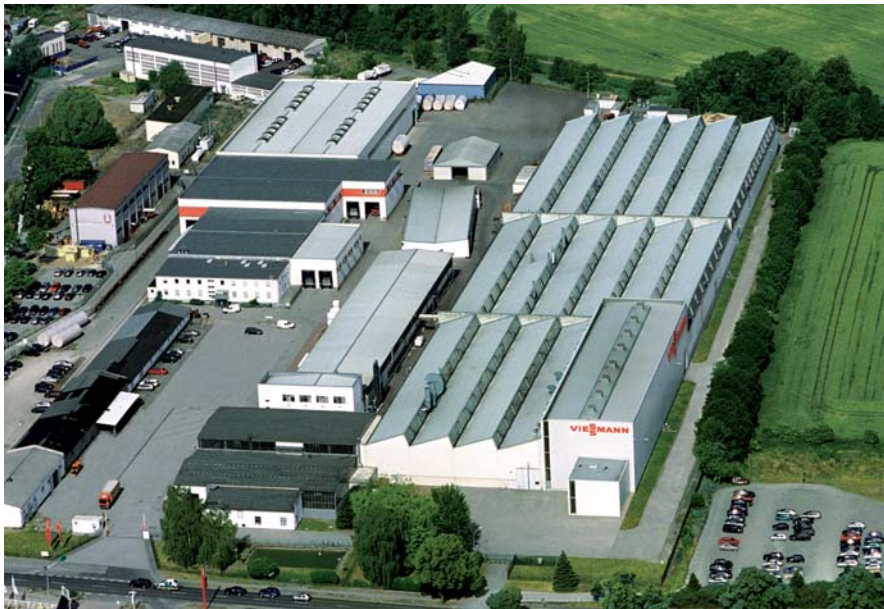
Großkesselfertigung im Werk Mittenwalde
