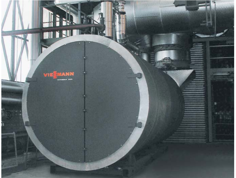
Bild 8: 2-Zug-Abhitzekessel zur Heißwassererzeugung
