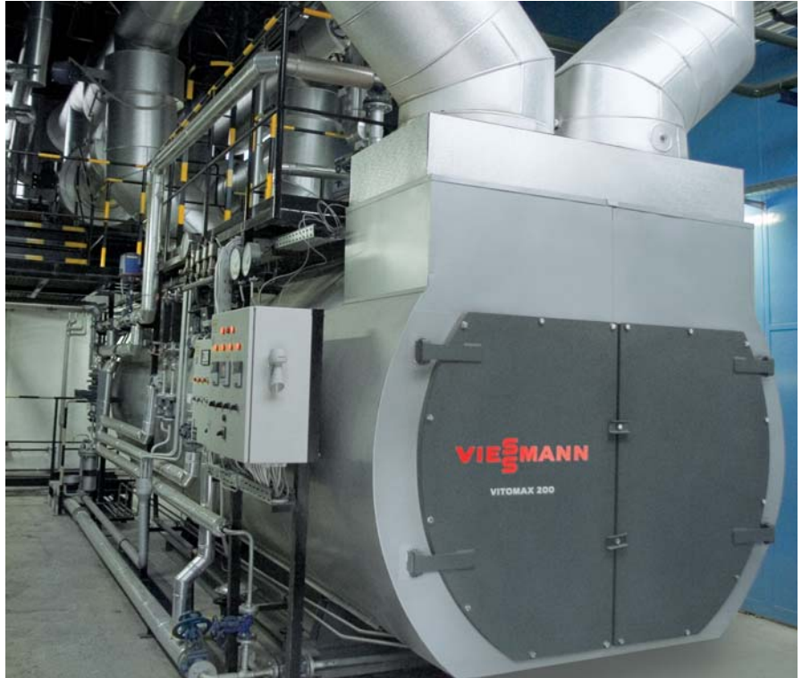
Bild 10: Abhitzekessel zur Dampferzeugung, 1-zügig für zwei Abgasquellen
