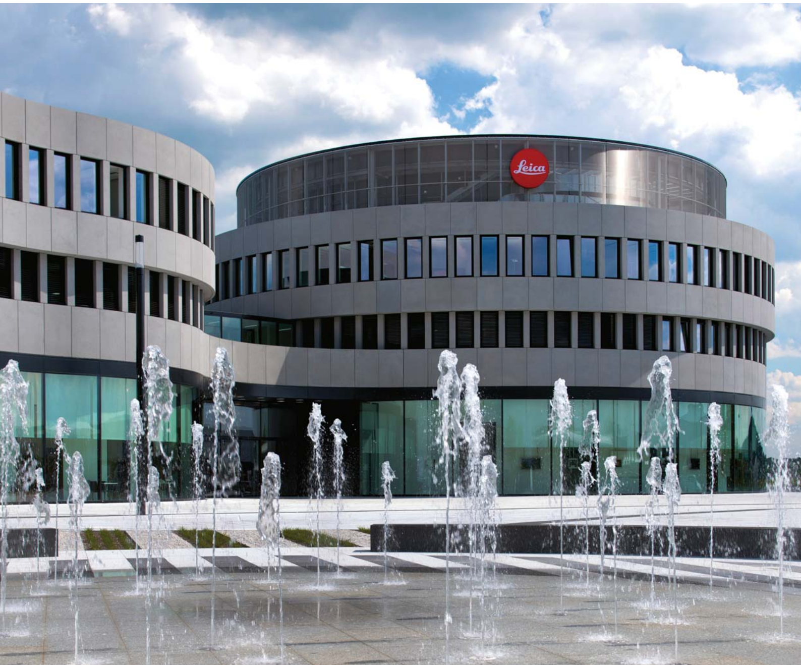
Im Erdgeschoss des neuen Verwaltungsgebäudes der Leica Camera AG in Wetzlar, Deutschland, wurden auch ein Museum und ein Flagship-Store eingerichtet.
