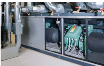
Sole/Wasser-Wärmepumpe mit 448 kW Heizleistung und 348 kW Kälteleistung
