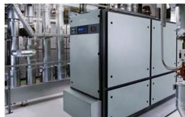
Kompaktes Blockheizkraftwerk Vitobloc 200 mit Leistungen von 140 kW el und 207 kW th
