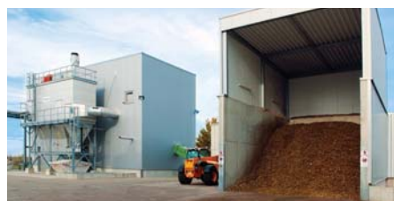
Die Heizzentrale mit Multizyklon und integriertem Elektrofilter (I.), im Vordergrund das Lager für Holzackschnitzel
