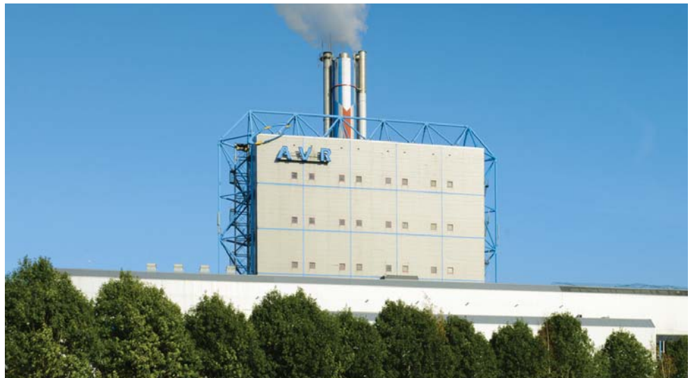
HKB Biomasseanlage AVR, Duiven, Niederlande
