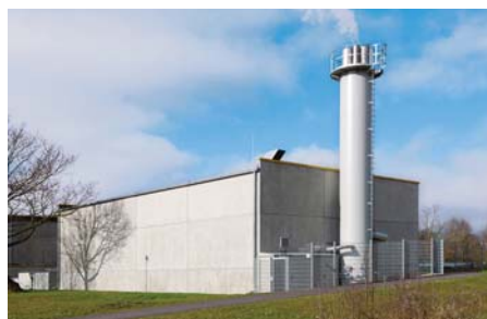
Heizwerk für das Nahwärmenetz in Memmingen
