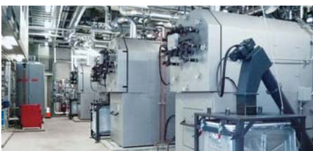
Holzheizkessel Vitoflex 300-UF mit Unterschubfeuerung
